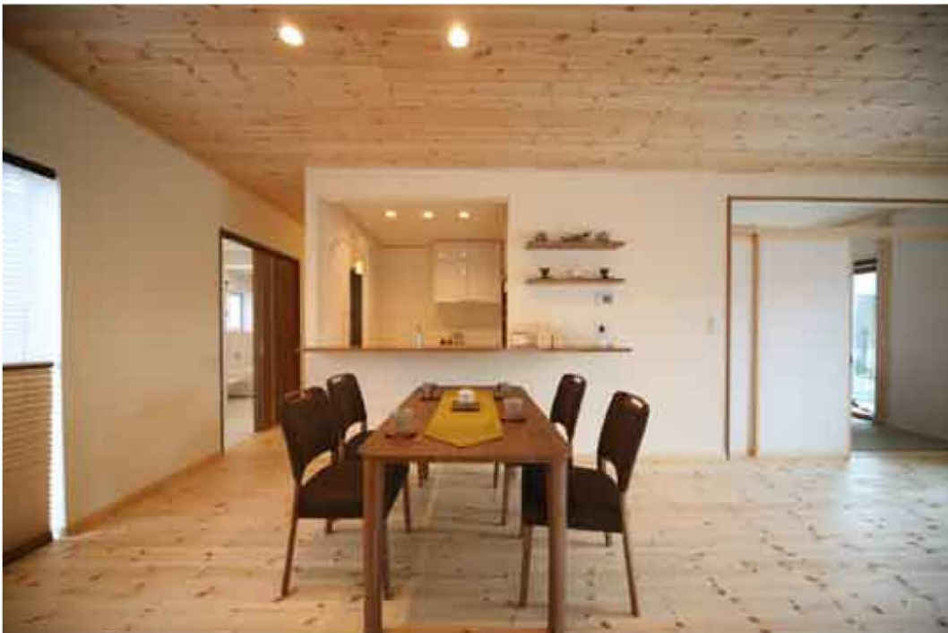
▲天井・床にパインの無垢材を、壁は珪藻土で仕上げた明るい空間。
